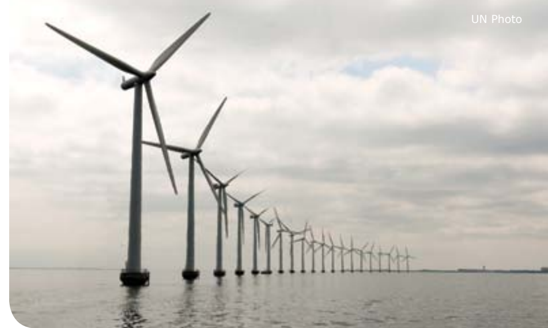
Middelgrunden Offshore Windpark in Dänemark
